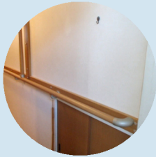
手すりの取り付け
